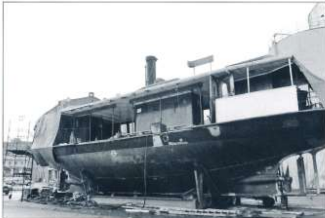
Här står färjan på Sörhallskajen på Eriksberg. Babords sida av överbyggnaden är bortskrotad för att ersättas med en ny. Skrovet är klart efter plåtbyte i vattenlinjen. Foto Åke Karlsson i slutet av september 1984.
