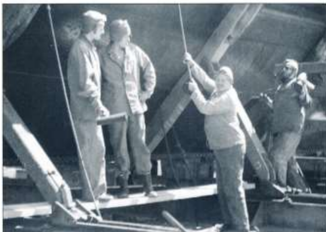
Botternmålning pågår med färjan på slipen vid Hammens uvar på Ringön. Från vänster Per Ahlquist, Per-Olof Falk, Lennart Berglund och Kaj Englund. Foto Gunnar Stålerberg juni 1973.
