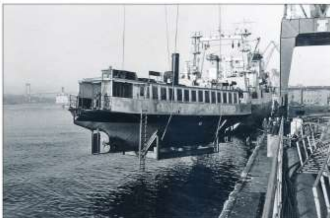
Färjan sjösätts på Eriksberg med hjälp av en av varvets 90-tonns kranar efter att ha stått på land för reparationer sedan 1981. Foto Åke Karlsson 23 september 1985.
